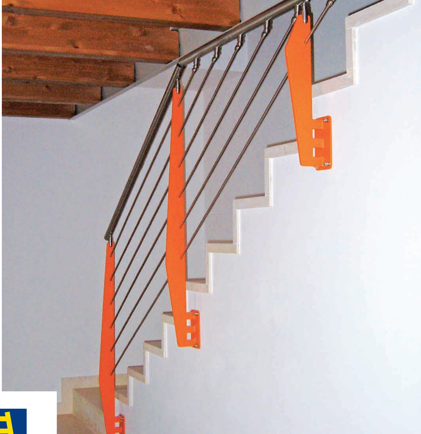
RINGHIERA IN FERRO E ACCIAIO INOX
