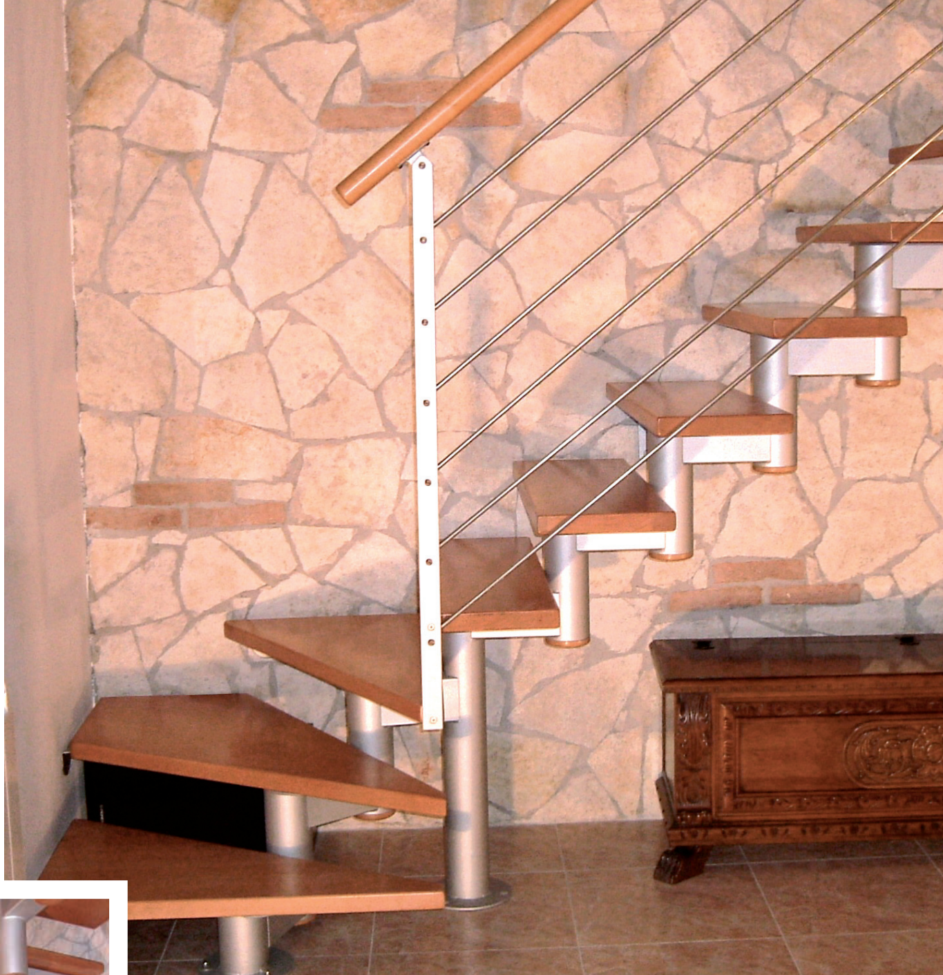
RINGHIERA CON DOPPIE PIANTANE IN FERRO, TONDINI ORIZZONTALI IN ACCIAIO INOX, CORRIMANO IN LEGNO
