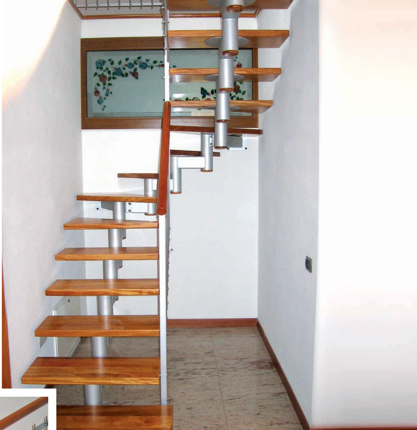
RINGHIERA IN FERRO, TONDINI VERTICALI IN ACCIAIO INOX, CORRIMANO IN LEGNO
