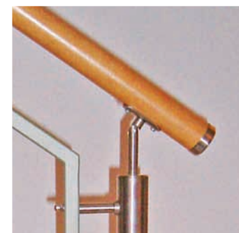
RINGHIERA IN FERRO E ACCIAIO INOX, CORRIMANO IN LEGNO
