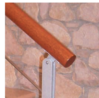
RINGHIERA CON DOPPIE PIANTANE IN FERRO, TONDINI ORIZZONTALI IN ACCIAIO INOX, CORRIMANO IN LEGNO
