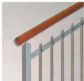
RINGHIERA IN FERRO, TONDINI VERTICALI IN ACCIAIO INOX, CORRIMANO IN LEGNO
