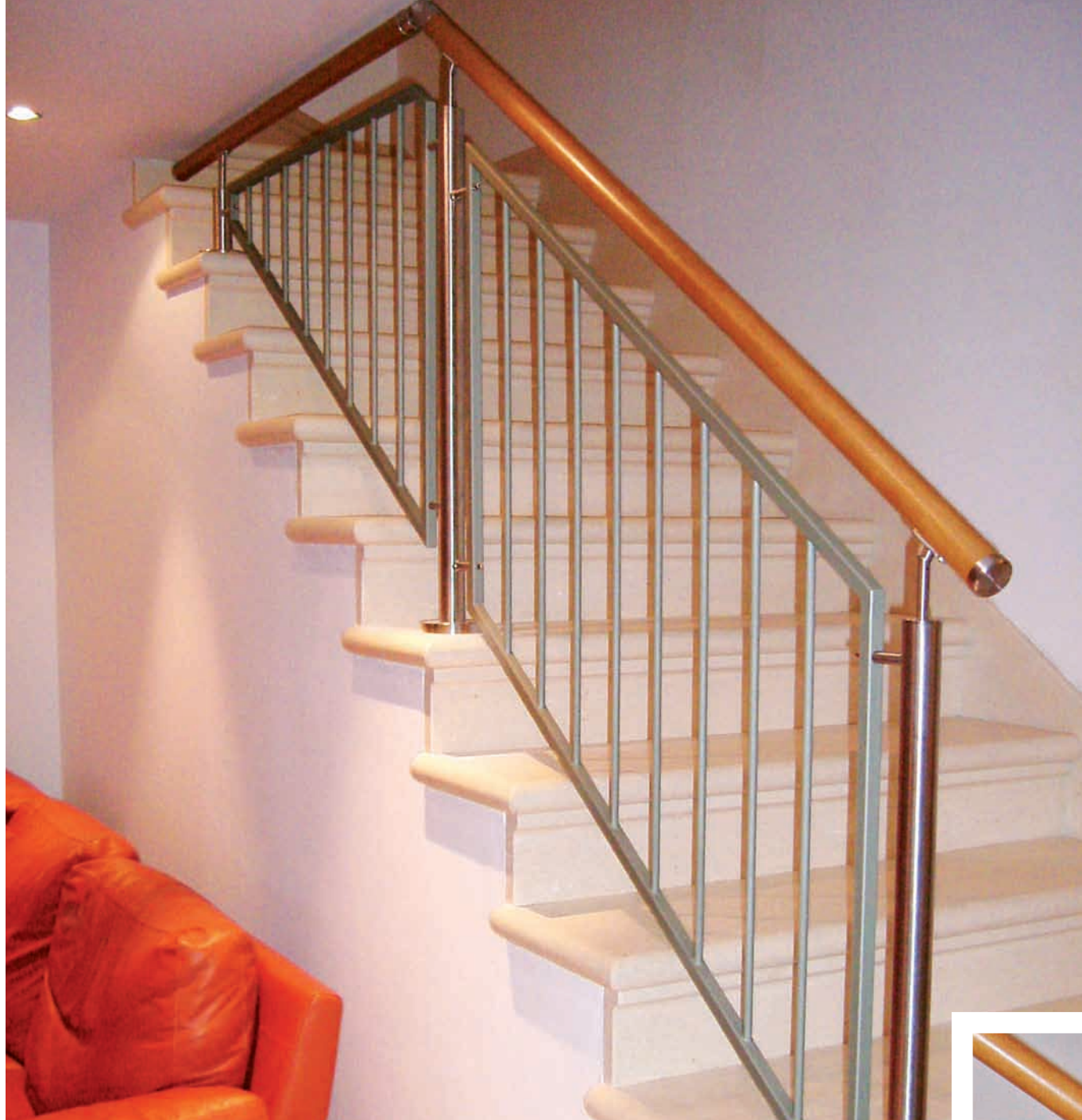
RINGHIERA IN FERRO E ACCIAIO INOX, CORRIMANO IN LEGNO
