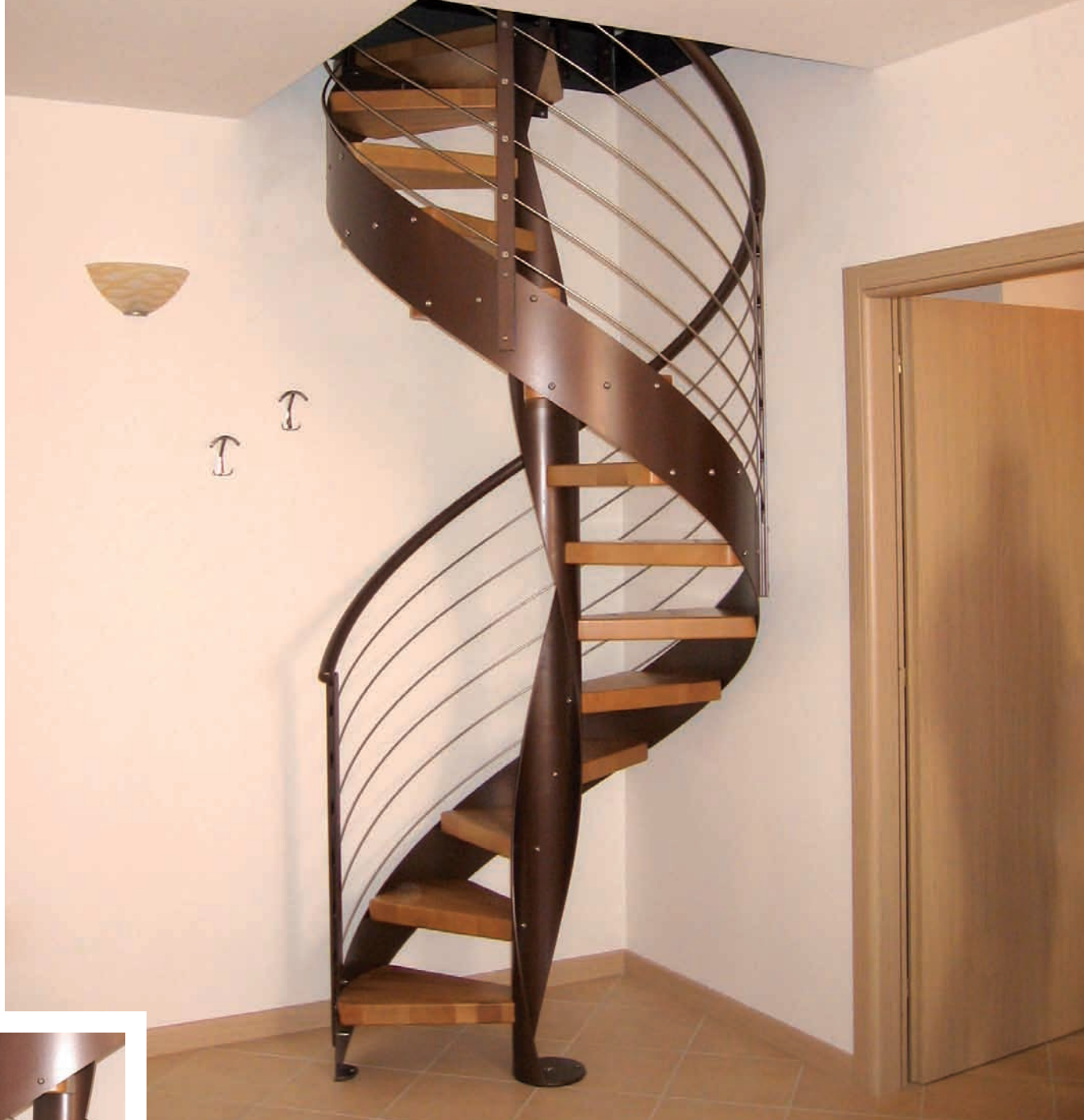
RINGHIERA CON DOPPIE PIANTANE IN FERRO, TONDINI ORIZZONTALI IN ACCIAIO INOX, CORRIMANO IN FERRO
